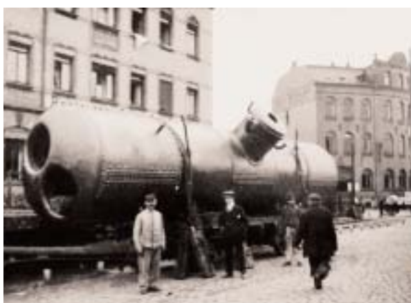
Siegfried Peretz AG Transport eines Kessels durch die Chemnitzer Innenstadt
